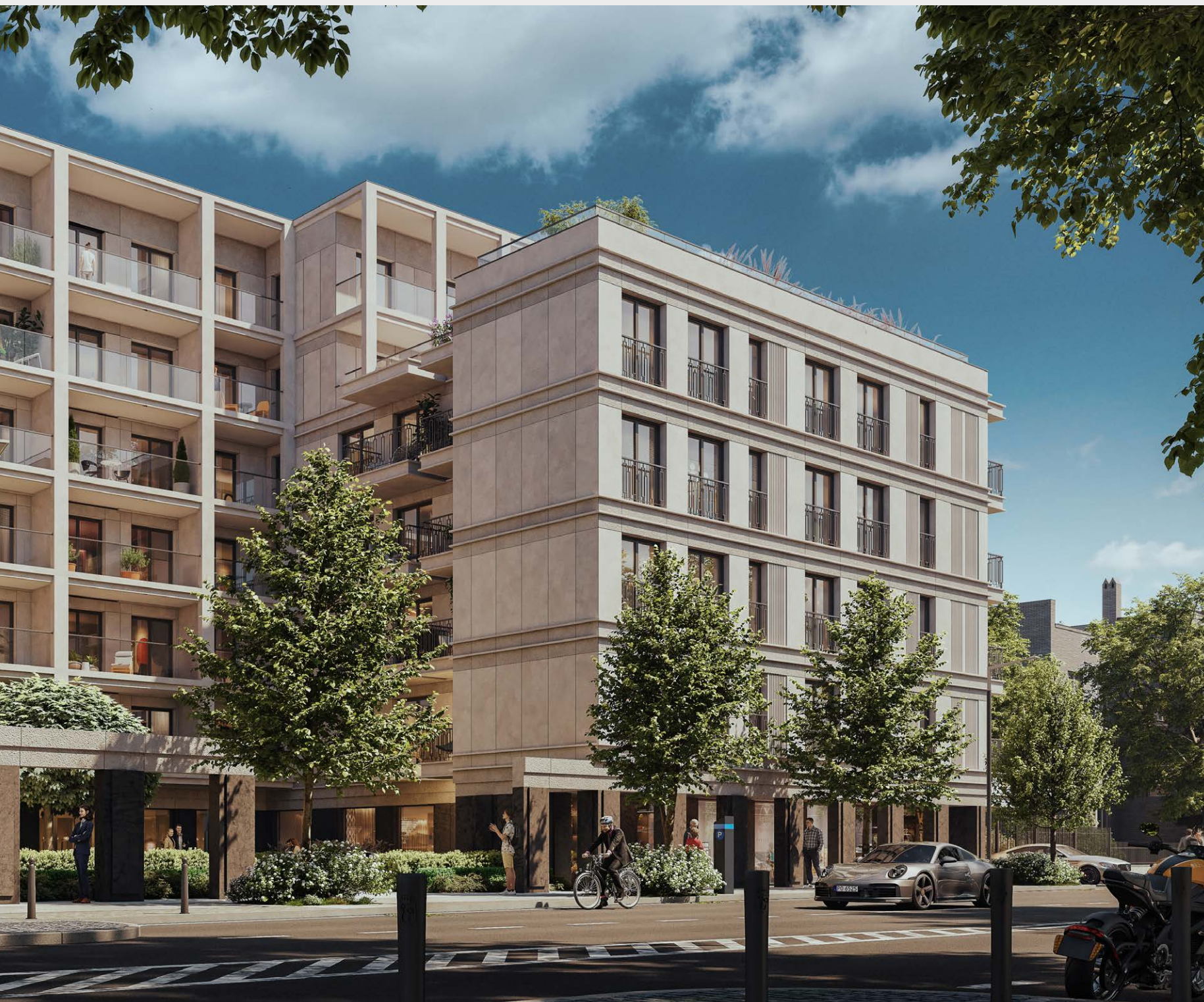
Konwiktorska Residence elewacja frontowa z zielonym patio
